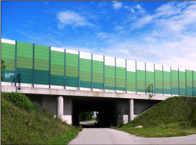
6.13 Autobahnunterführung der A99
