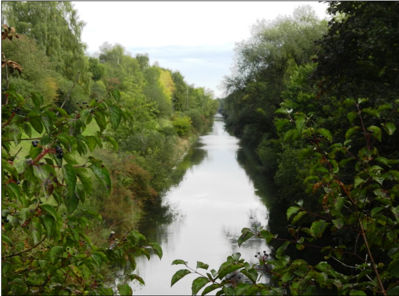
6.9 Abfanggraben an der Fasanenallee
