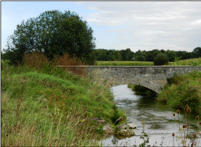
6.3 Brücke des namenlosen Feldweges zwischen Pellegrinistraße und Lebermoosweg
