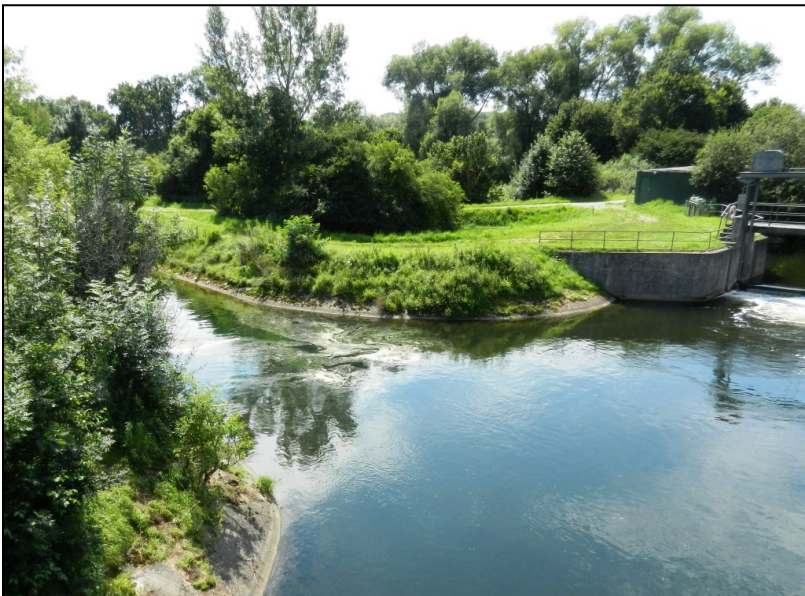
6.23 Nördliche Variante: Mündung des Abfanggraben in den Speichersee
