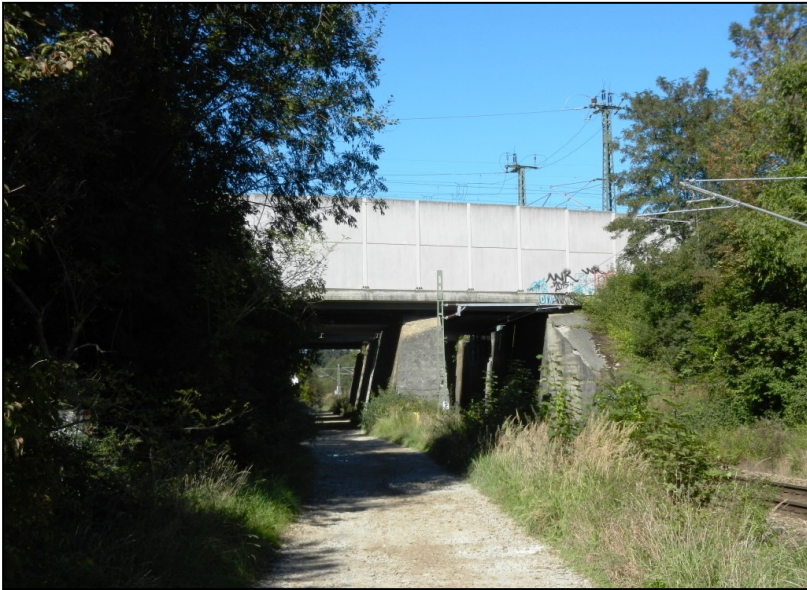
5.5 Ein Kiesweg unterquert die S-Bahn S 2
