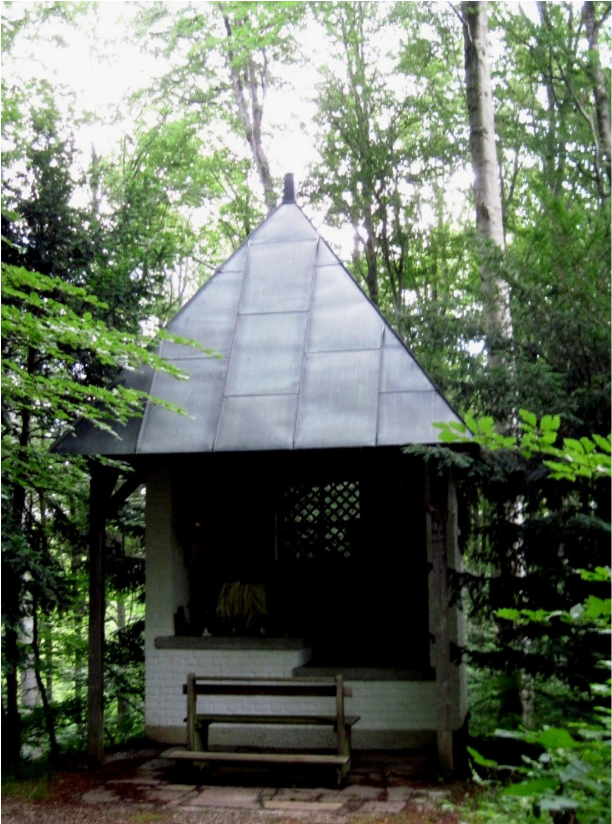
Bergkapelle (Pöcking - Possenhofen) Ettaler Straße 82343 Pöcking
