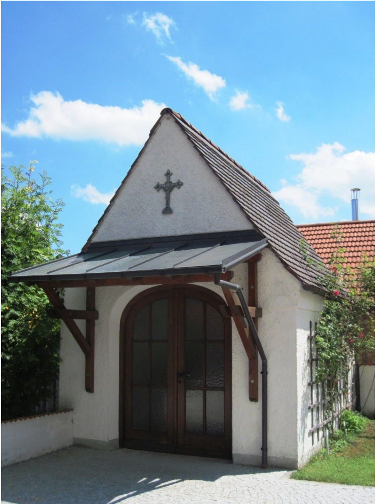
Aussegnungshalle bei St. Margarete (Seefeld, Meiling) Dorfstraße 82229 Seefeld
