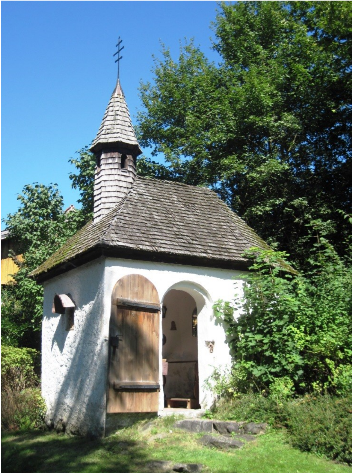
Dorfkapelle (Berg - Assenhausen) Dürnbergstraße 82335 Berg
