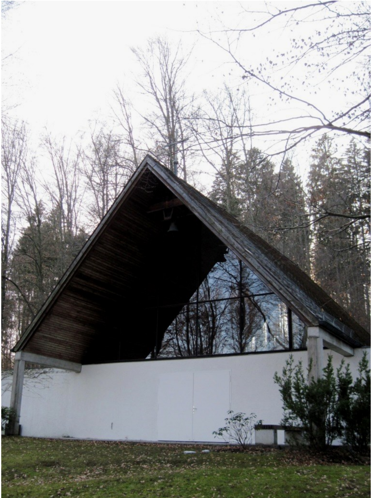
Aussegnungshalle Waldfriedhof (Starnberg) Waldfriedhof 82319 Starnberg
