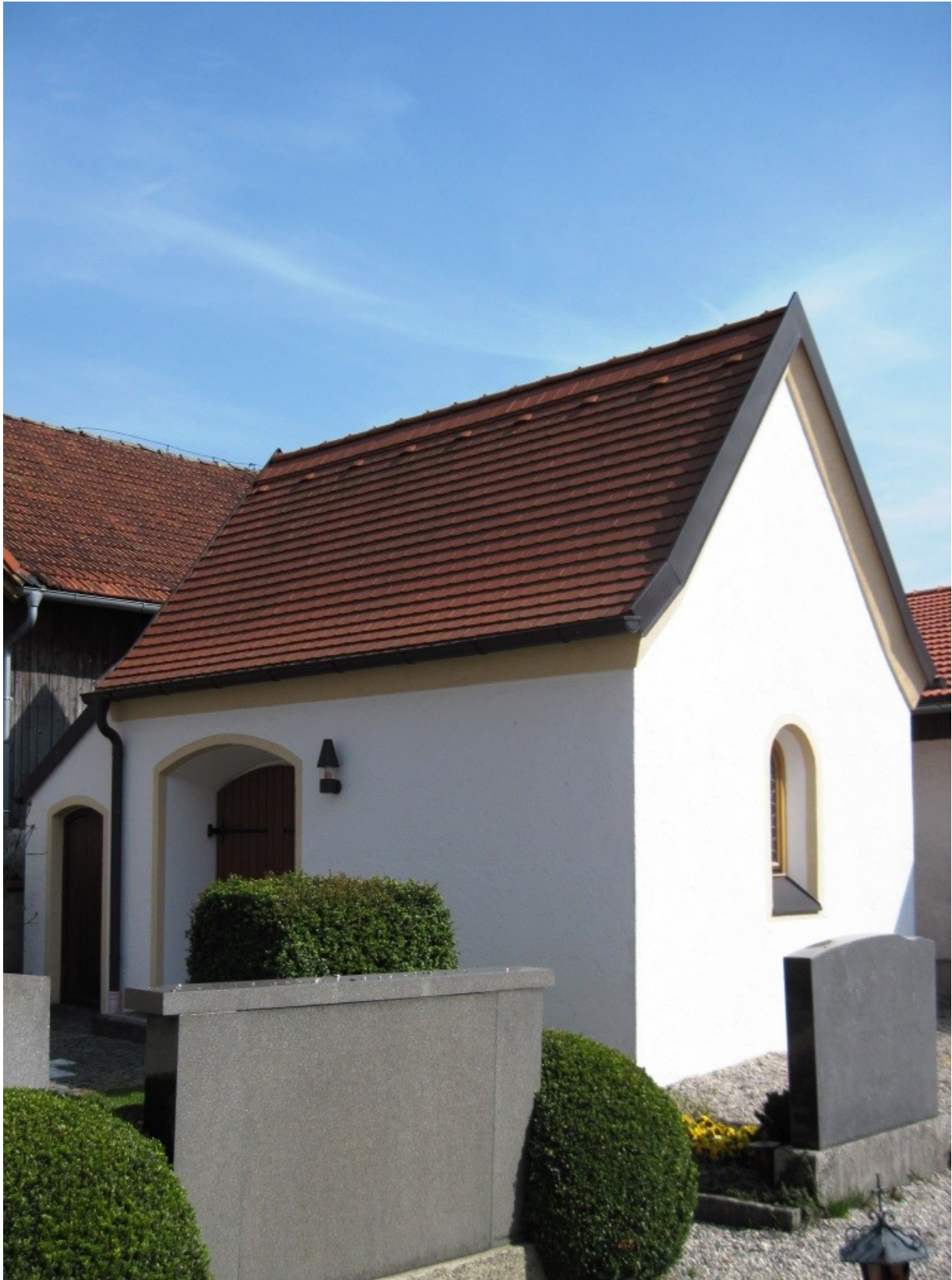
Aussegnungshalle bei St. Jakob (Weßling, Hochstadt) Dorfstraße 82234 Weßling
