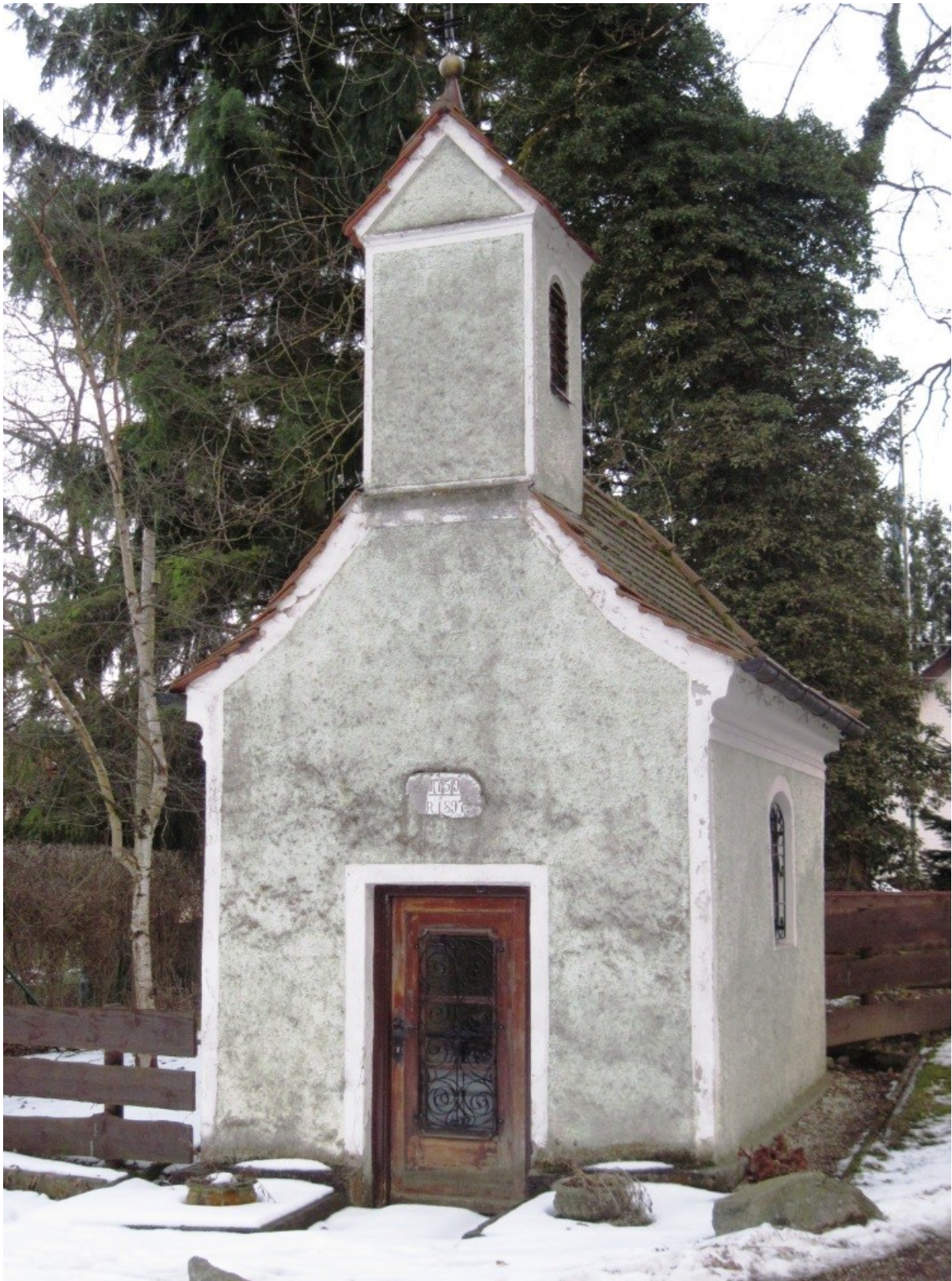
St. Maria, Gutskapelle (Schorn) Gutshof 82319 Starnberg
