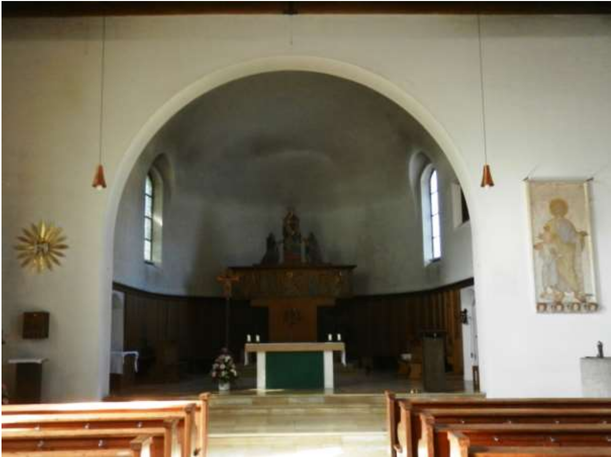
Saalbau mit Flachdecke und Apsis, von Richard Steidle (Architekt), 1936/37
