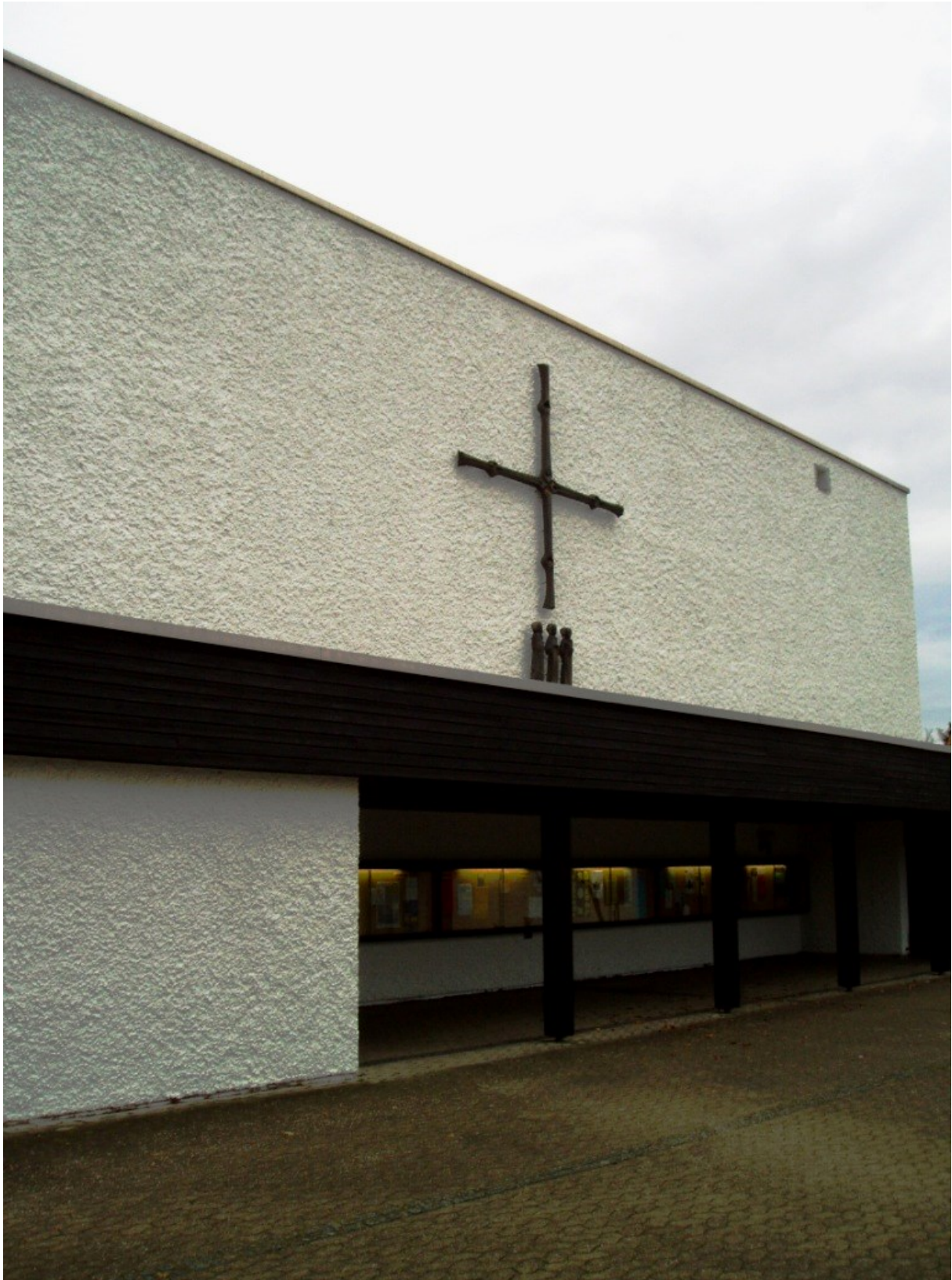
Verklärung Christi (Ramersdorf) Adam-Berg-Straße 40 81735 München
