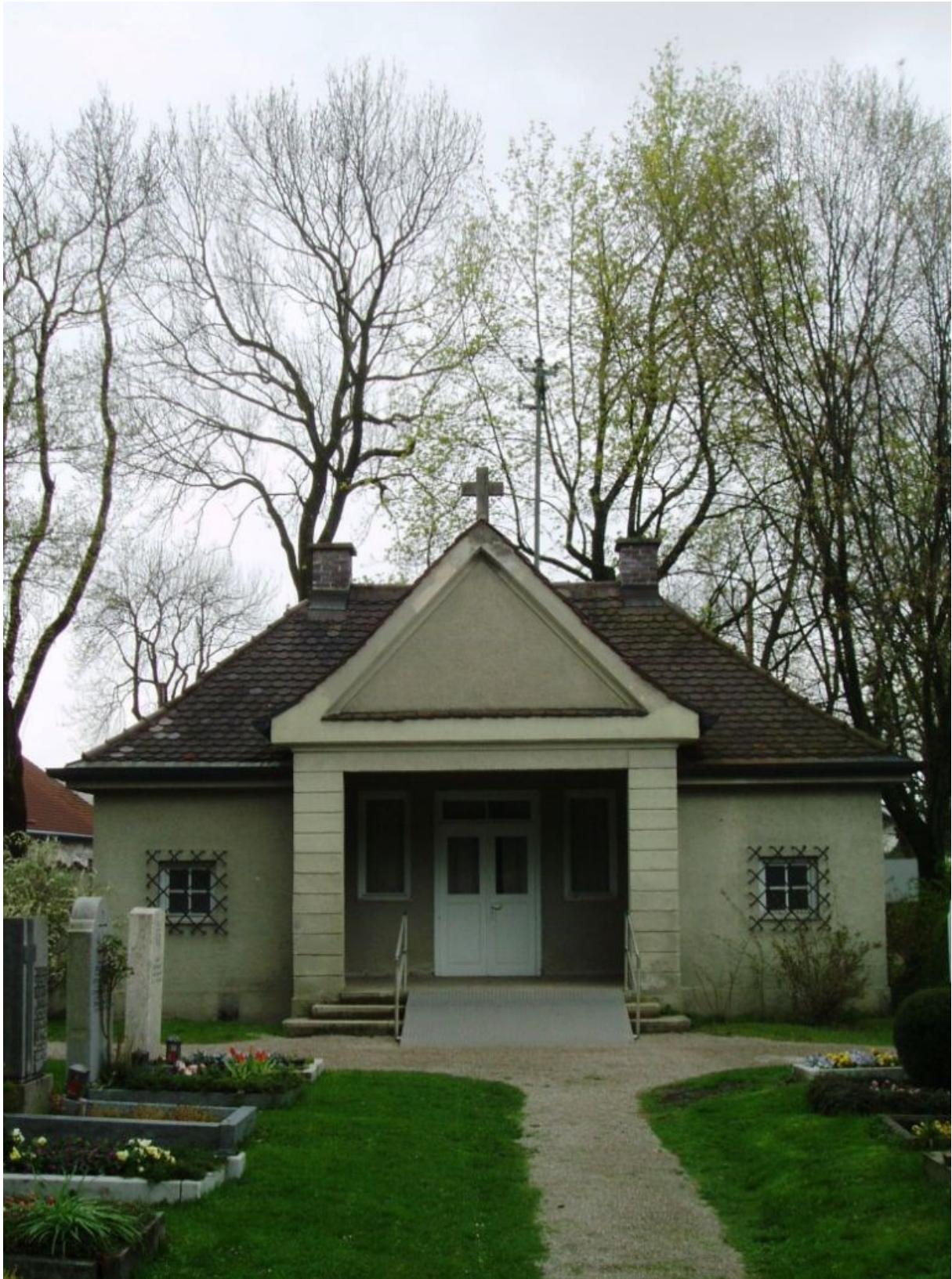
Aussegnungshalle, Friedhof Dagfing Kohlbrennerstraße 19 81929 München
