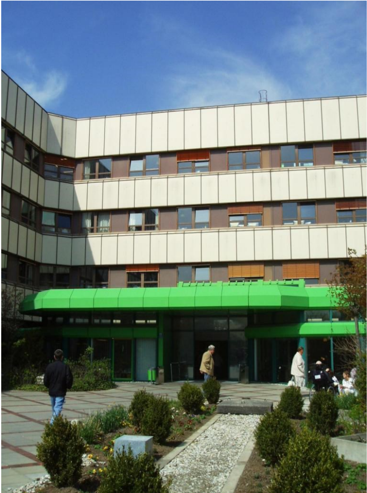
Städtisches Krankenhaus Bogenhausen, Kapelle (Bogenhausen) Engschalkinger Straße 77 81925 München
