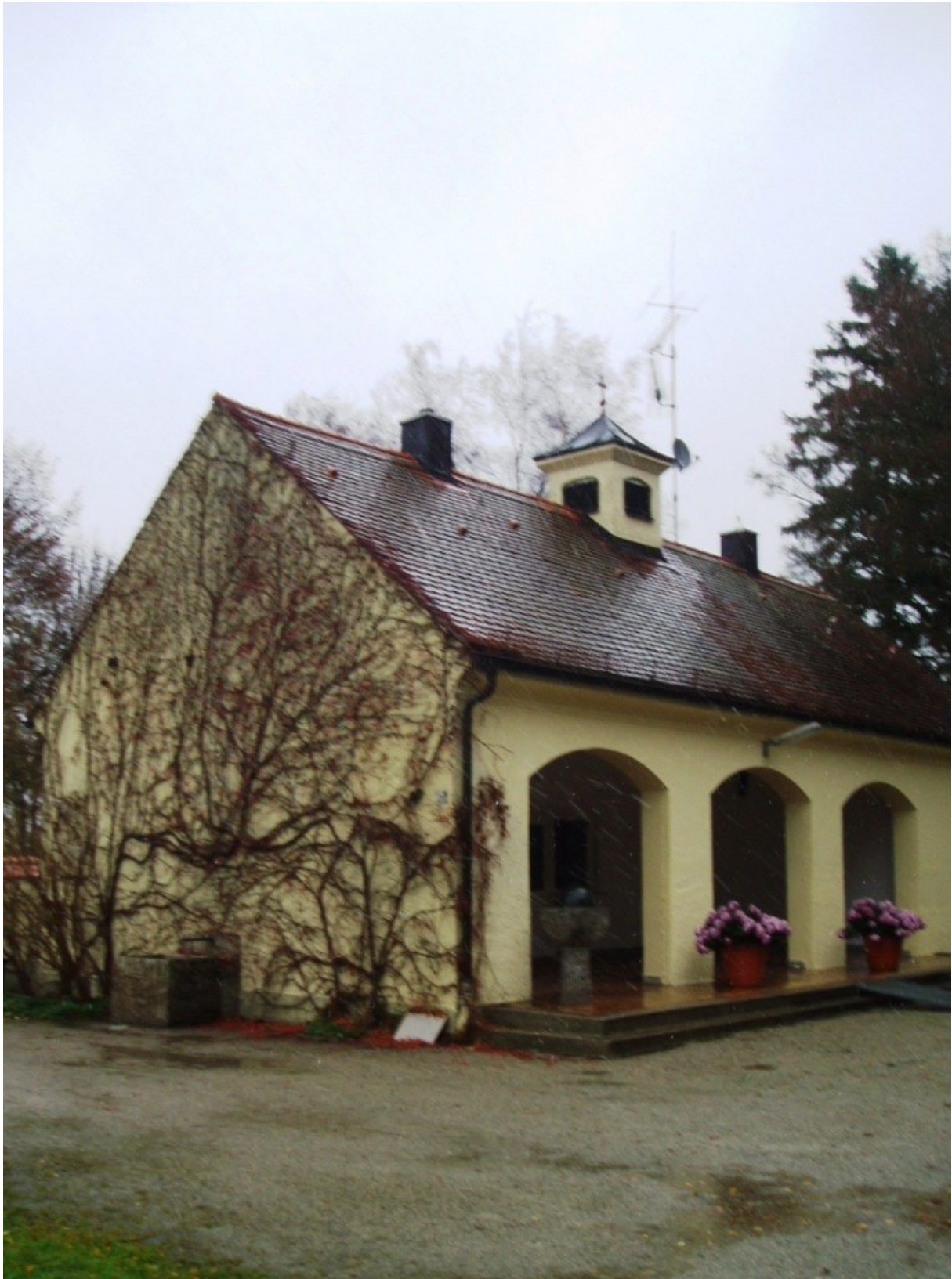
Aussegnungshalle, Friedhof Lochhausen Schussenrieder Straße 36 81249 München
