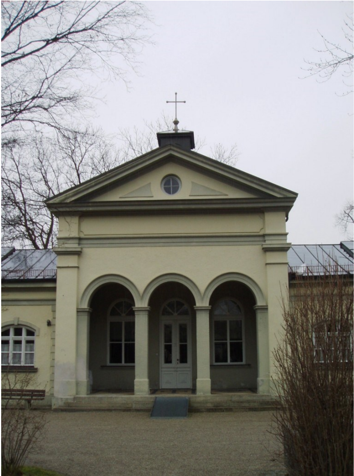
Aussegnungshalle, Friedhof Perlach Putzbrunner Straße 51 817397 München
