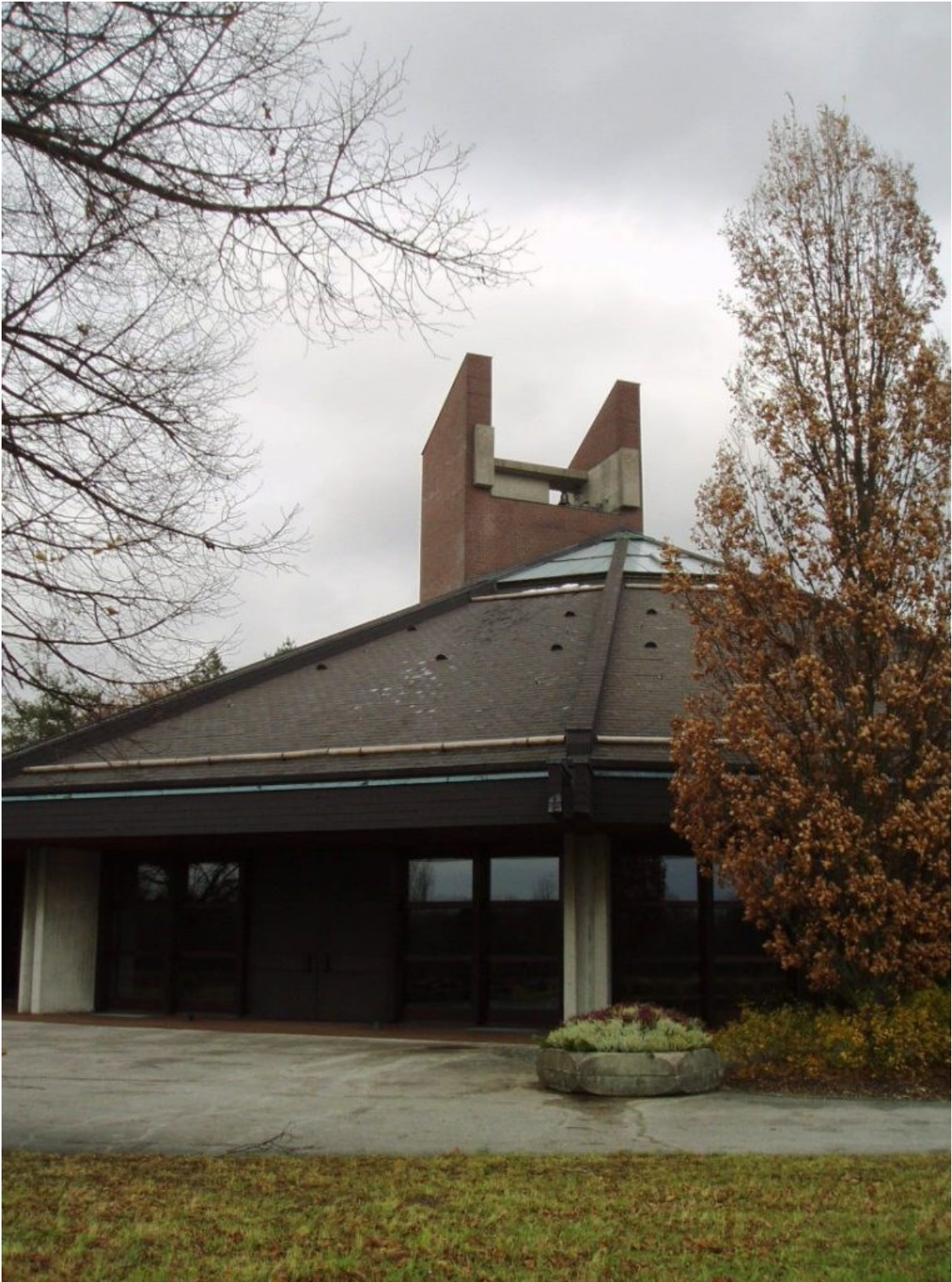
Aussegnungshalle, neuer Südfriedhof (Perlach) Hochäckerstraße 90 81737 München
