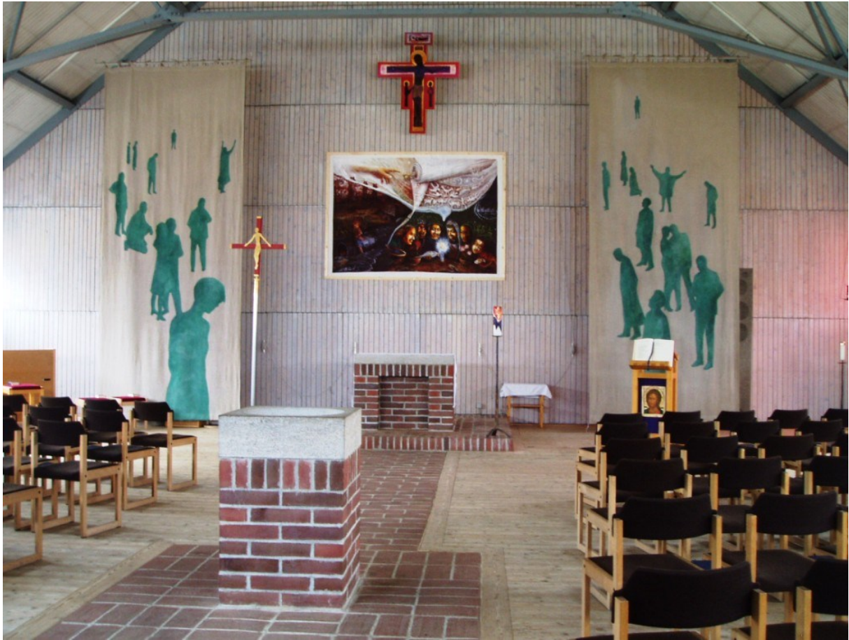
Die Kirche Königin der Märtyrer ist ursprünglich eine Notkirche, die 1997 an diesen Platz versetzt wurde. Die Außenwände des gestreckten Saalbaus sind holzverschalt, der Dachstuhl mit Metallunterzügen ist offen sichtbar.
