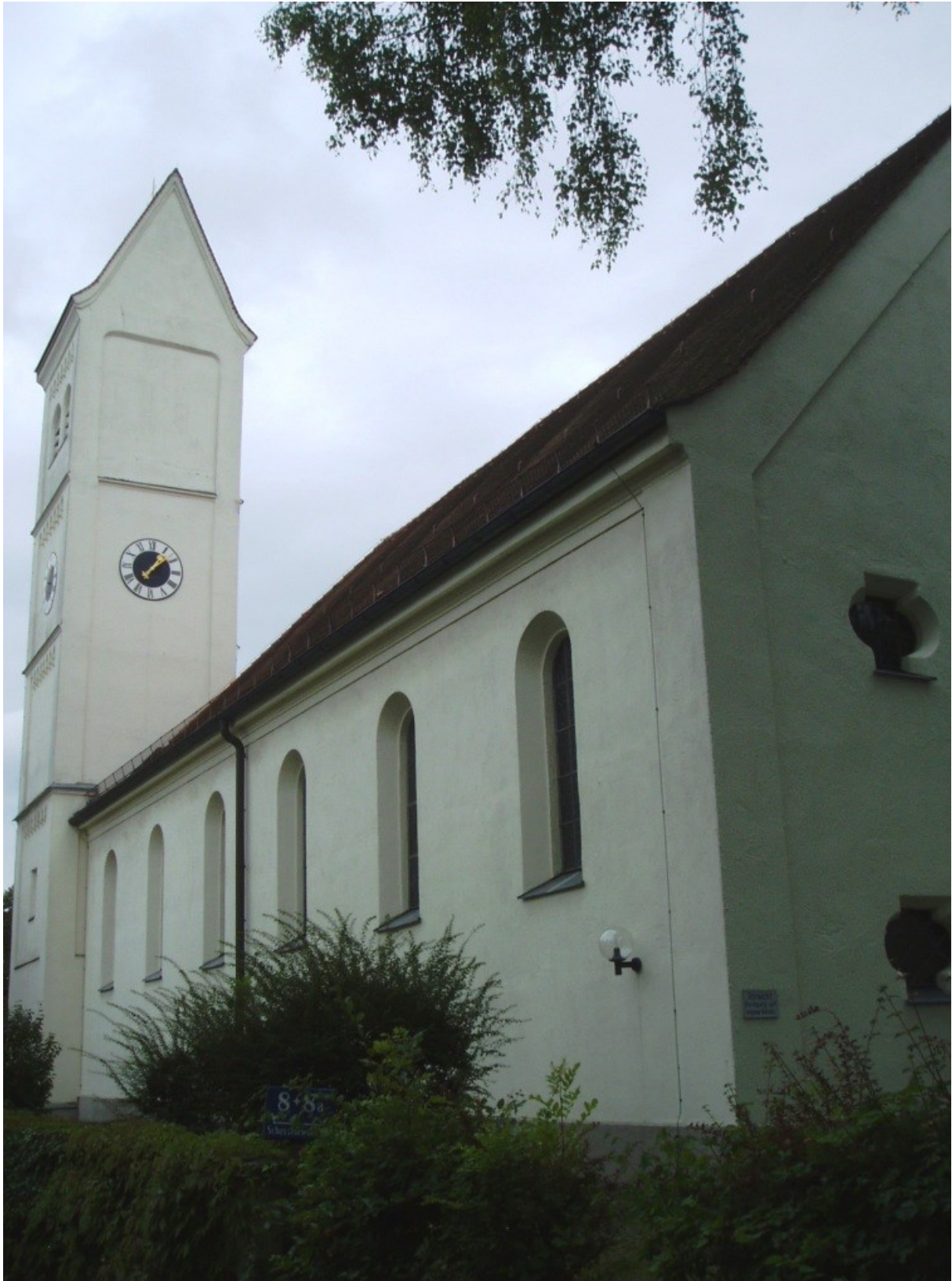
St. Michael (Lochhausen) Schussenrieder Straße 6 81249 München
