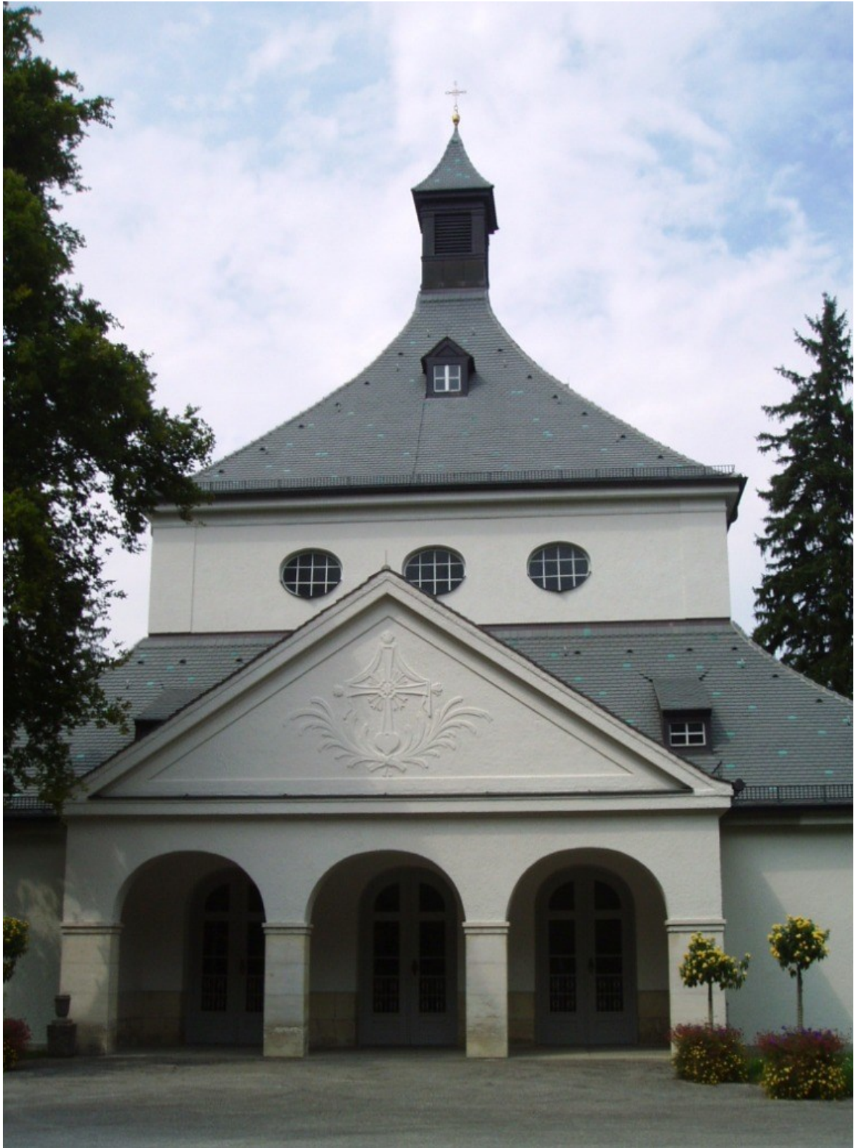
Aussegnungshalle, Waldfriedhof alter Teil (Großhadern) Fürstenrieder Straße 288 81377 München
