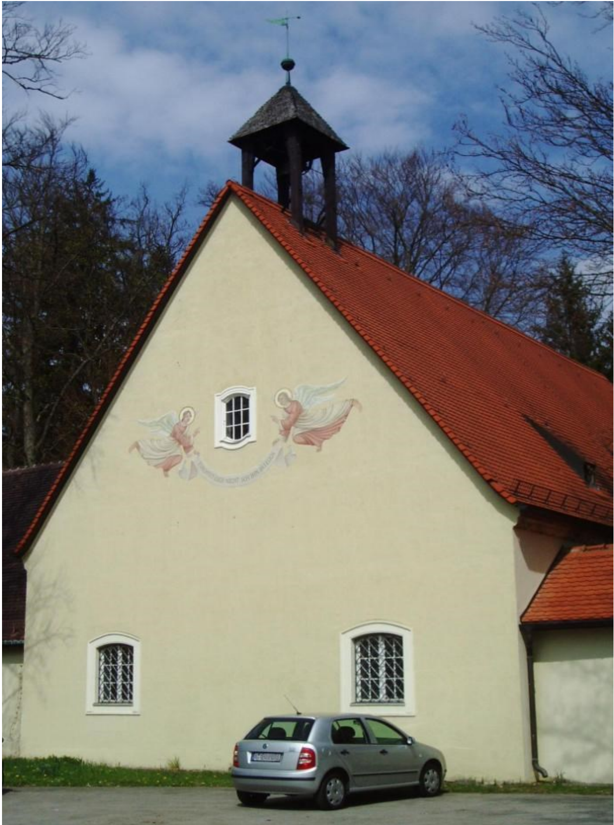
Aussegnungshalle, Waldfriedhof Solln Warnbergstraße 2 81479 München
