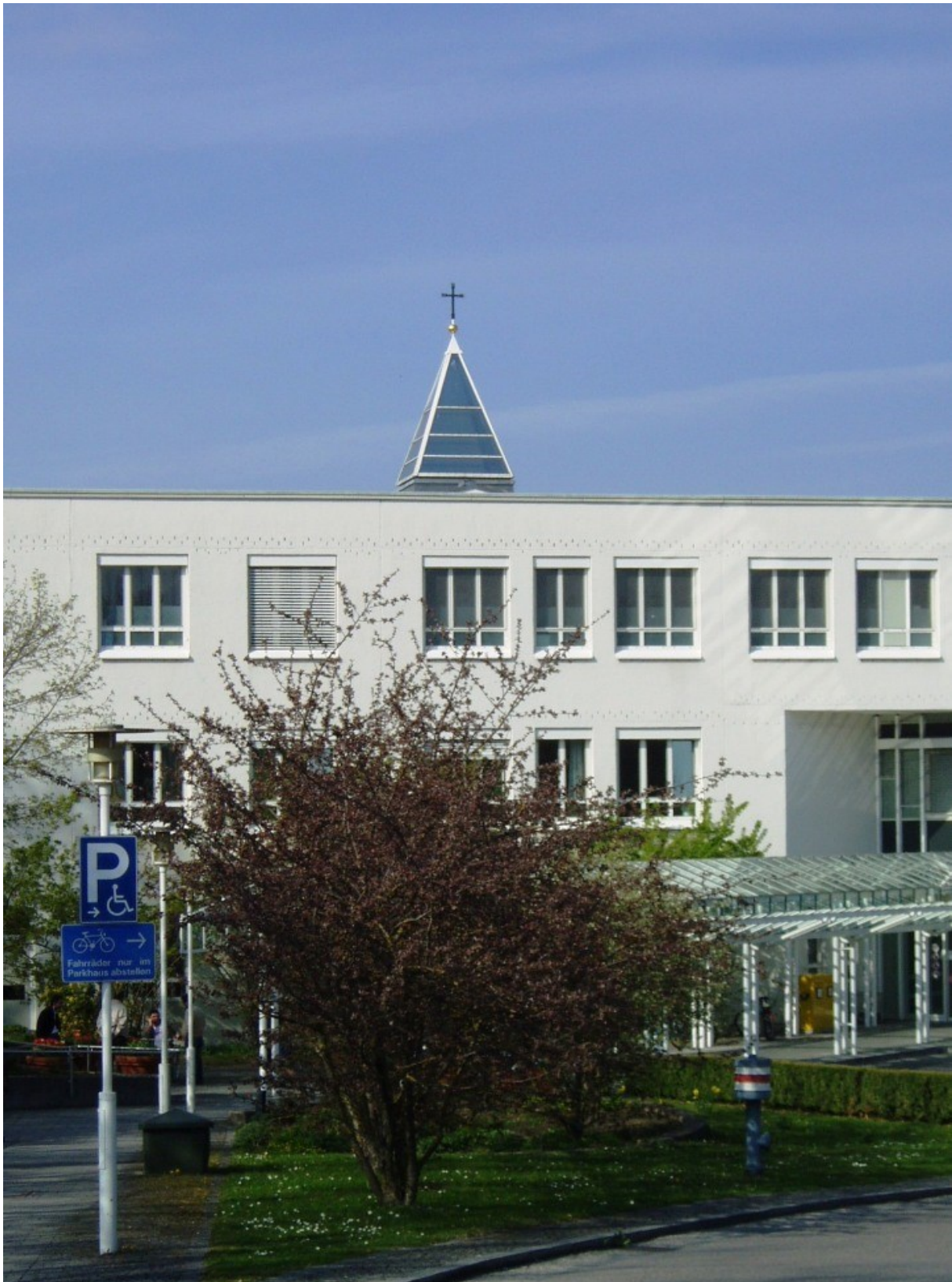
Krankenhaus Dritter Orden, Kirche und Kapelle (Nymphenburg) Menzinger Straße 44 80638 München
