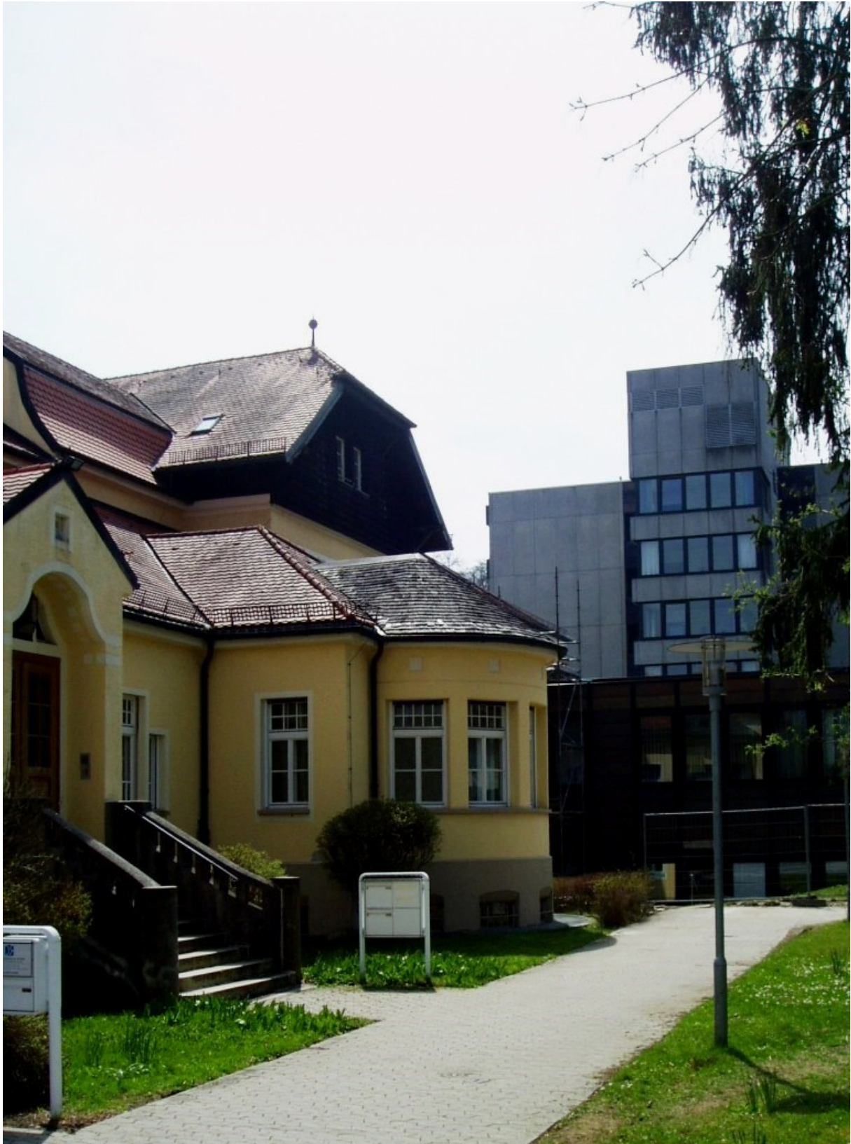
Krankenhaus Martha-Maria, Kapelle (Solln) Wolfratshauer Straße 101 81479 München
