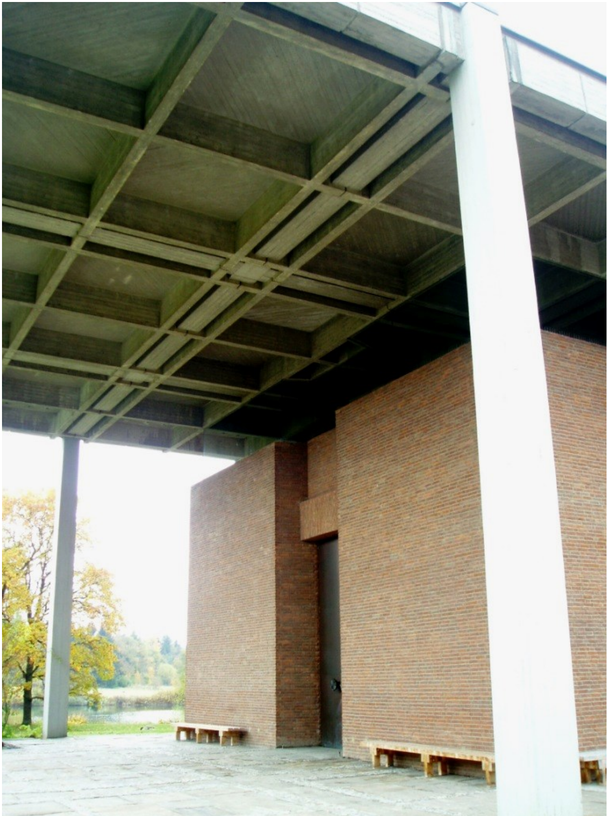
Aussegnungshalle, Waldfriedhof neuer Teil (Großhadern) Lorettoplatz 81377 München
