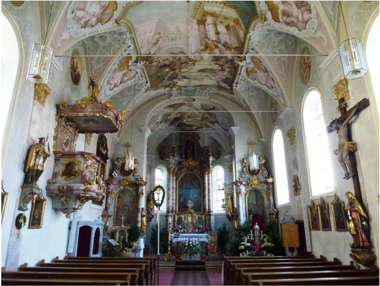
Die katholische Pfarrkirche St. Lorenz ist ein spätgotischer Saalbau mit eingezogenem Polygonalchor und Nordturm mit Zwiebelhaube, 15. Jahrhundert, ausgebaut 1603, barockisiert 1756 - 1758.
