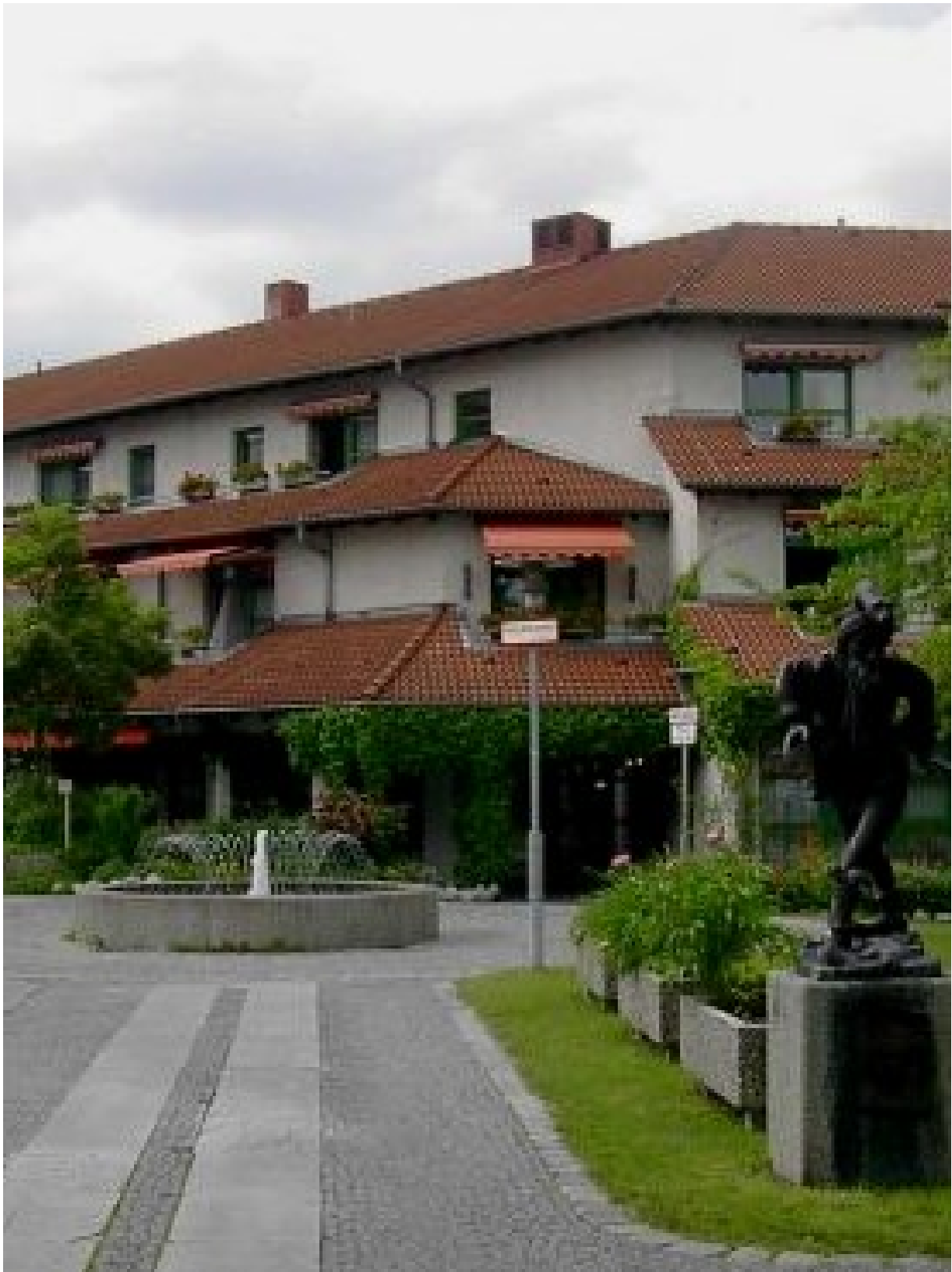
Kapelle im Laurentius Altenheim (Olching) "FA, FI" Feurstraße 23 82140 Olching
