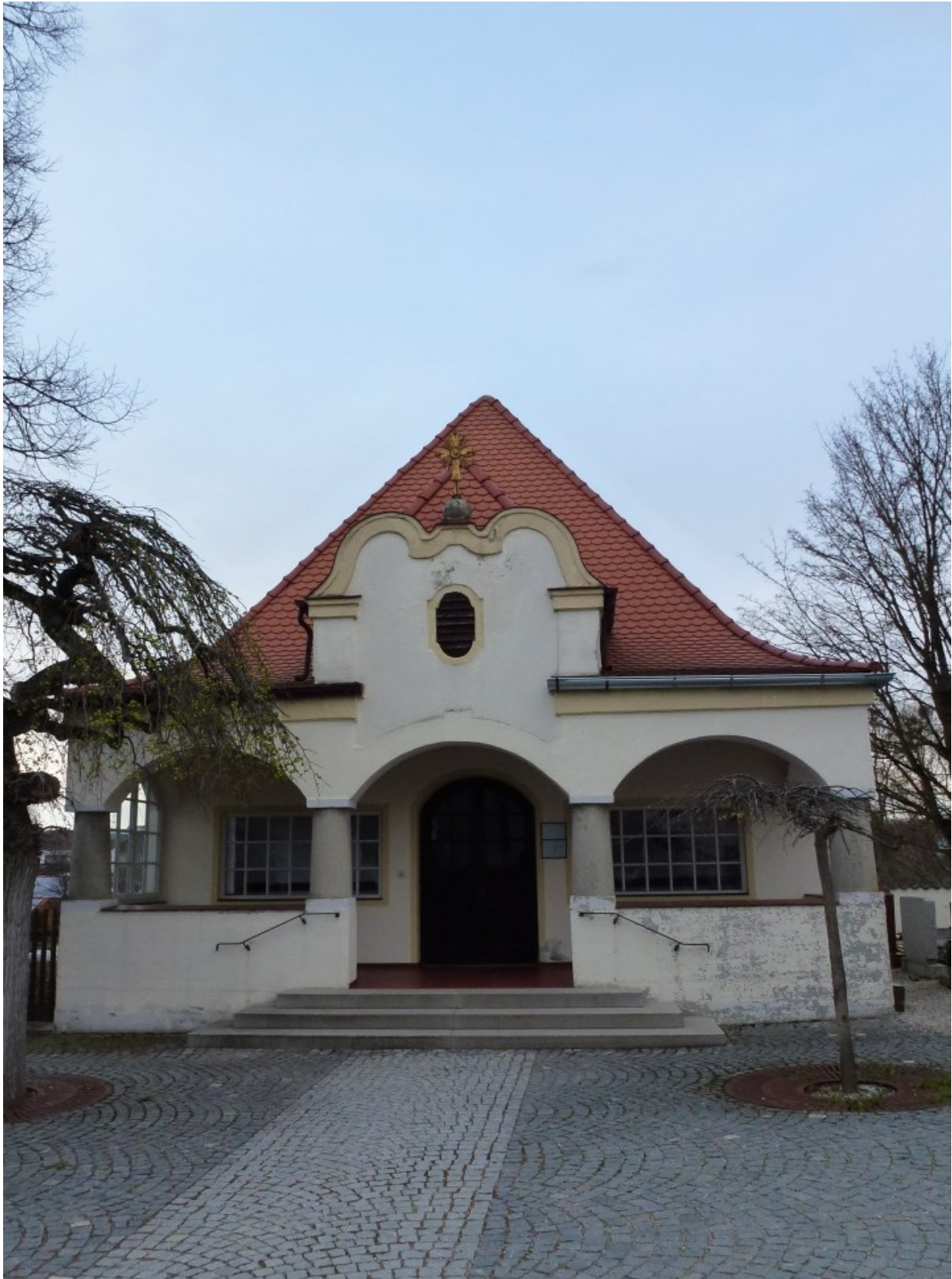
Aussegnungshalle bei St. Marä Himmelfahrt (Türkenfeld) Kirchstraße 82299 Türkemfeld
