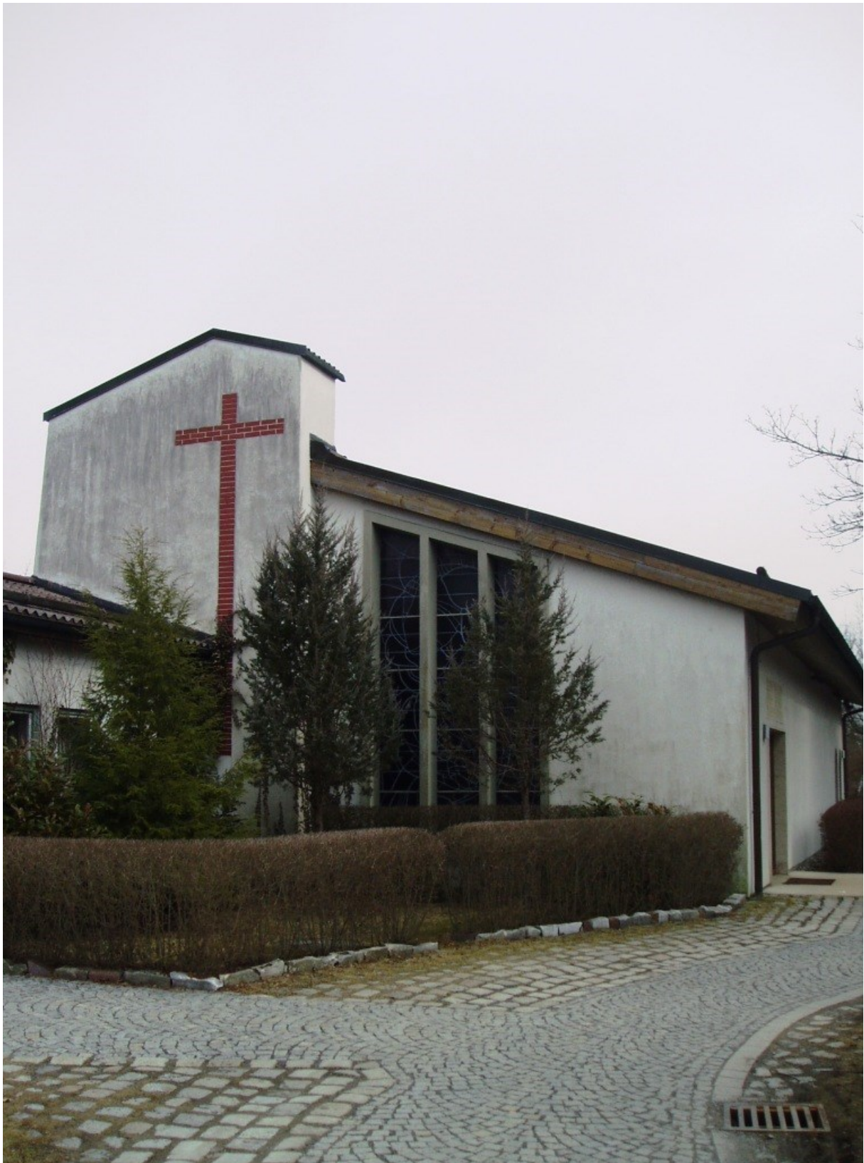
Aussegnungshalle im Waldfriedhof (Germering-Unterpfaffenhofen) Friedhofstraße 82110 Germering
