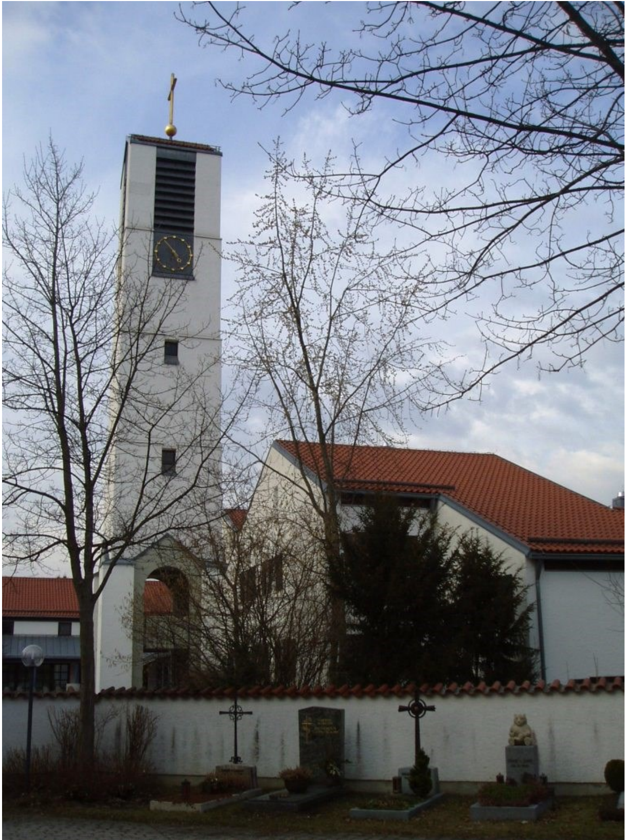
St. Martin (Putzbrunn) Kirchenzentrum 85640 Putzbrunn
