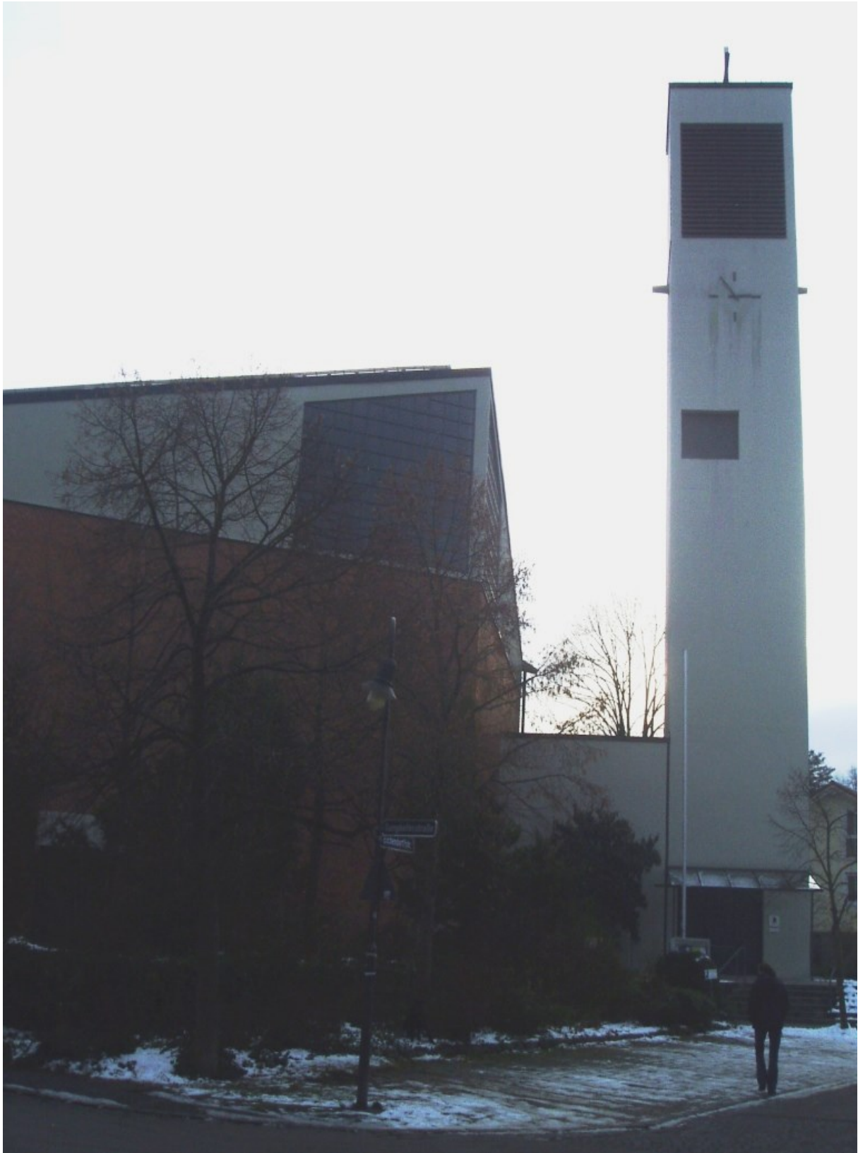
St. Michael (Ottobrunn) Ganghoferstraße 28 85521 Ottobrunn
