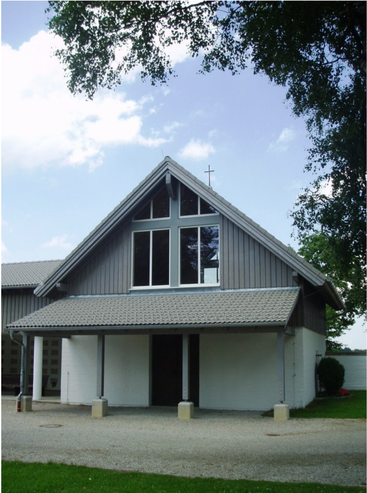
Aussegnungshalle (Straßlach) Mühlstraße 82064 Straßlach
