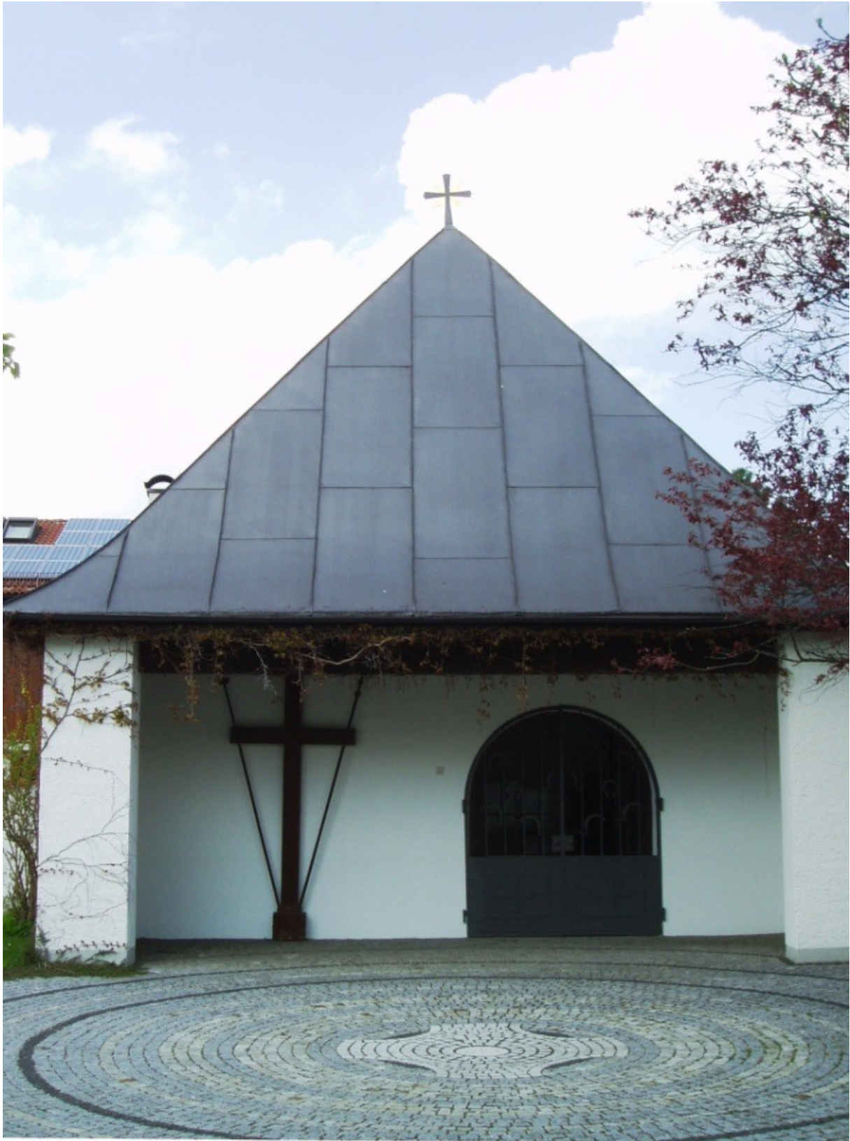
Aussegnungshalle bei St. Mariä Geburt (Höhenkirchen) Schulstraße 1 85635 Höhenkirchen-Siegertsbrunn
