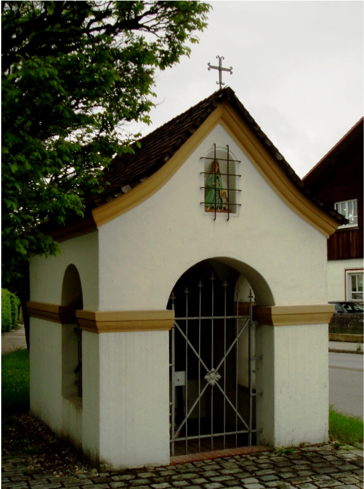
Wegkapelle (Oberhaching) Tölzer Straße 82041 Oberhaching
