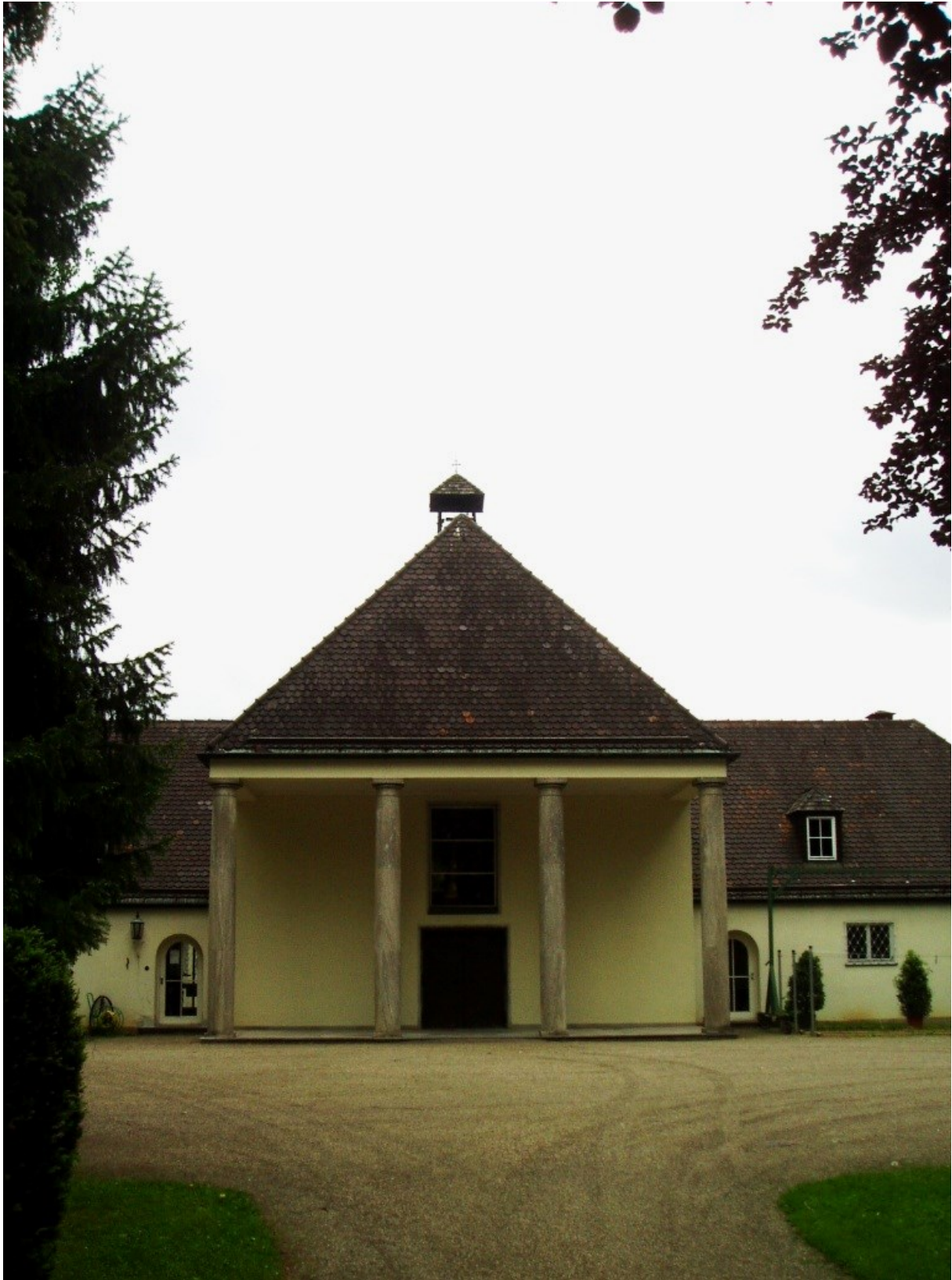
Aussegnungshalle (Pullach) Münchner Straße 82049 Pullach
