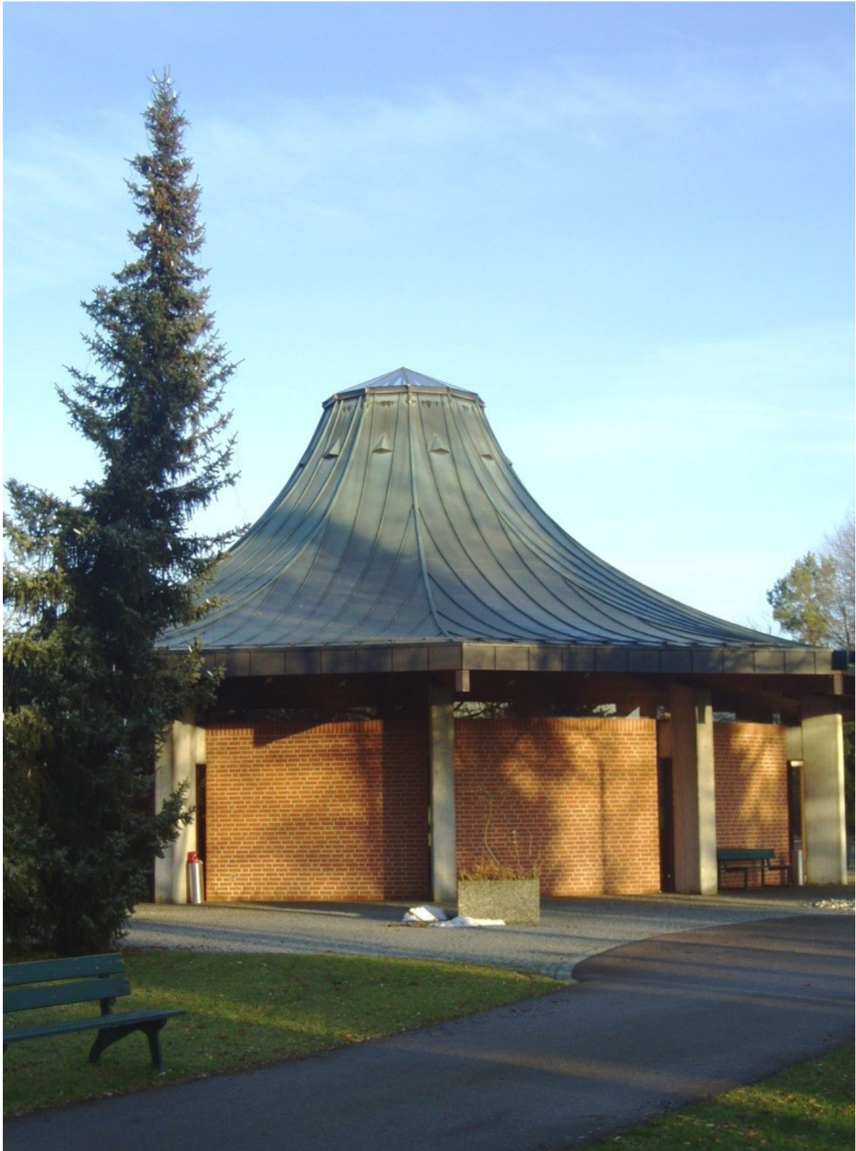
Aussegnungshalle (Unterhaching) Otto Brunner Straße 82008 Unterhaching
