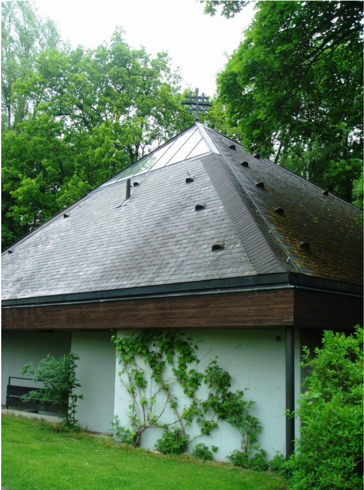
Friedenskirche (Gräfelfing) Zugspitzstraße 82166 Gräfelfing
