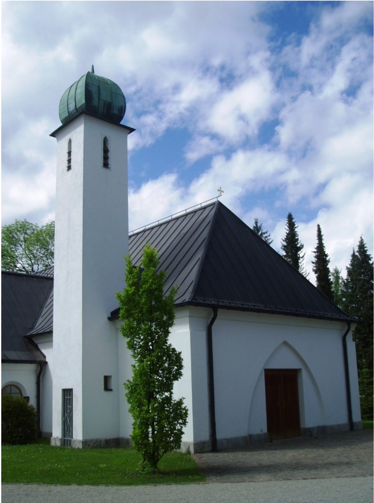
Aussegnungshalle (Planegg) Fürstenrieder Straße 82152 Planegg
