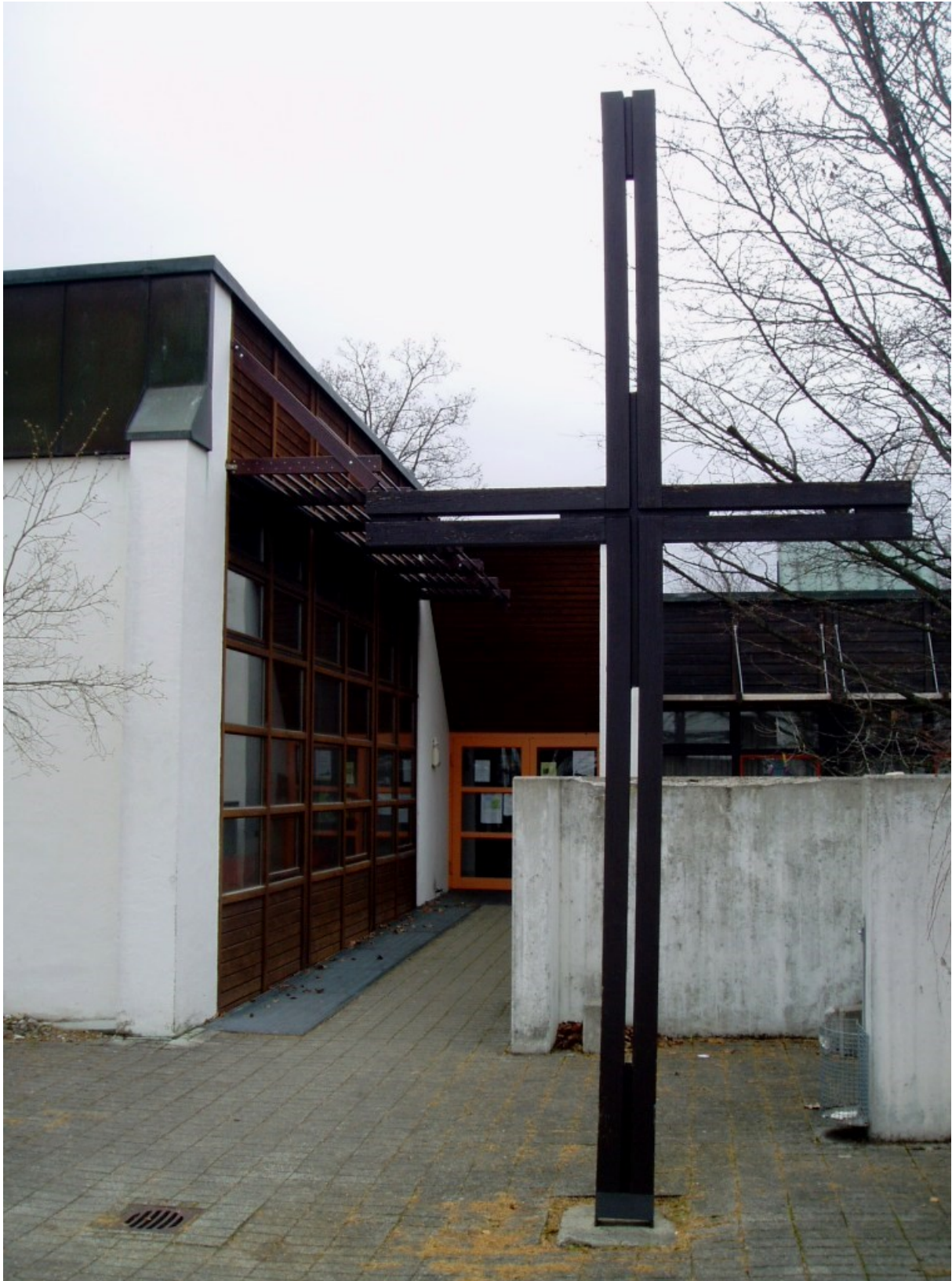
Gemeindeforum und Pfarramt (Unterhaching, Fasanenpark) Parkstraße 9 82008 Unterhaching
