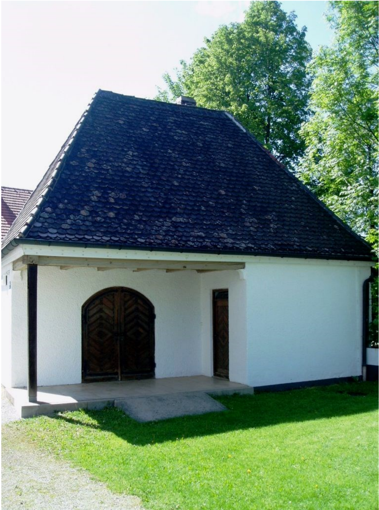
Aussegnungshalle bei St. Nikolaus (Brunnthal) Otterloher Straße 85649 Brunnthal
