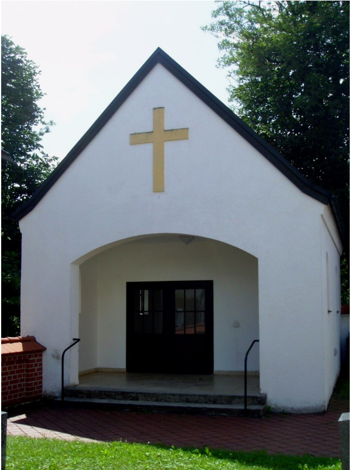
Aussegnungshalle bei St. Andreas (Grasbrunn, Harthausen) Kirchenstraße 85630 Grasbrunn
