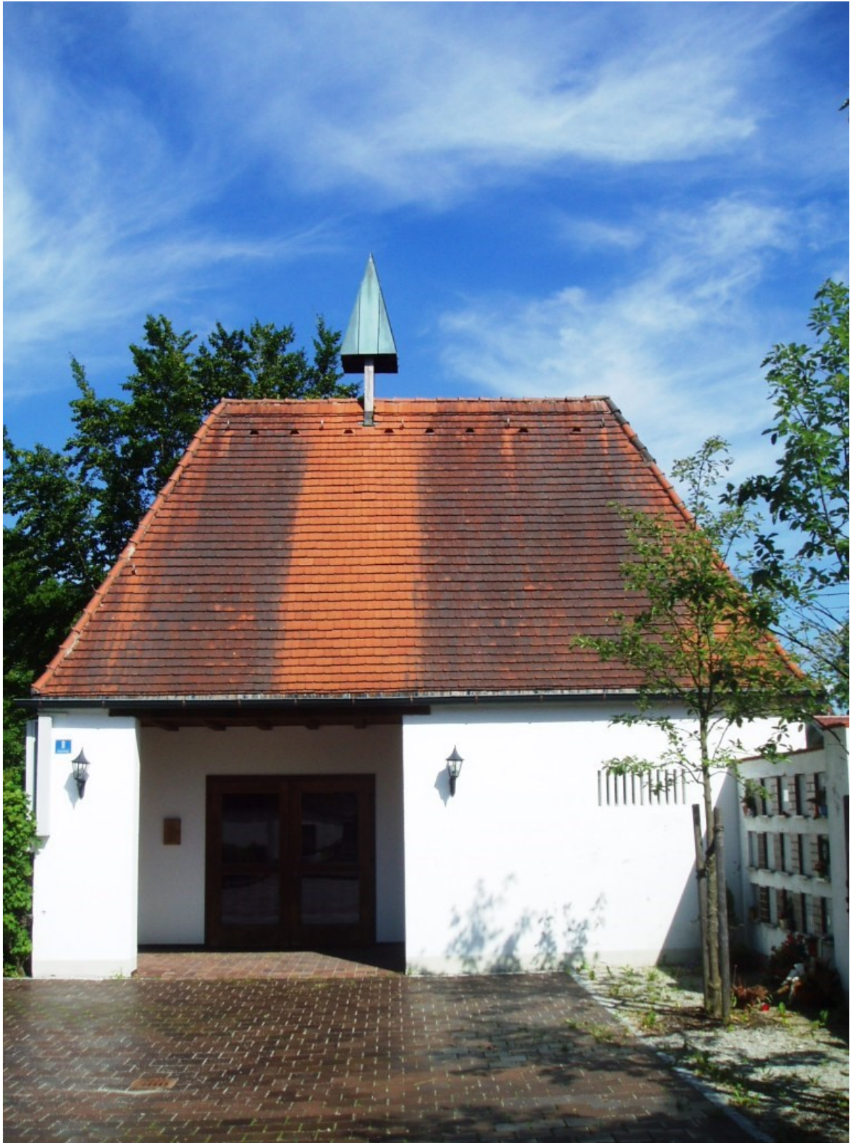
Aussegnungshalle bei St. Emmeram (Aying, Kleinhelpendorf) Kleinhelpendorf 8 85653 Aying
