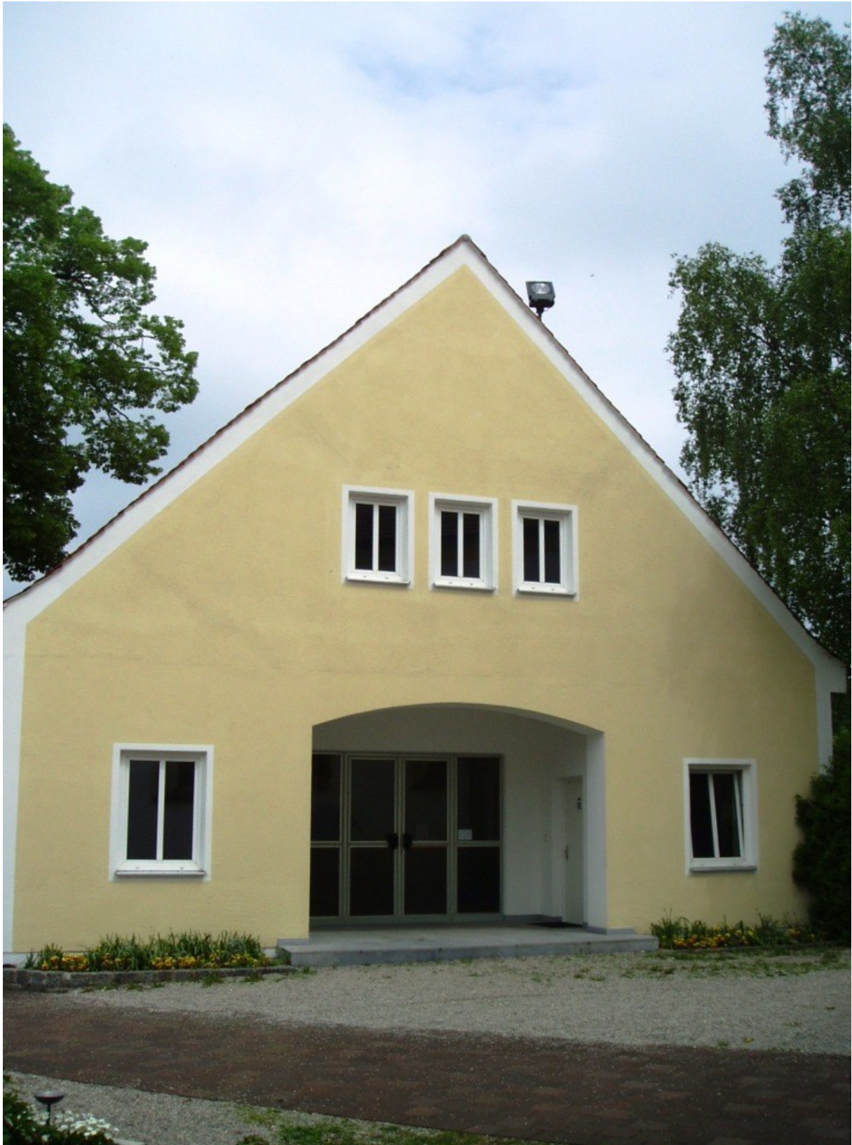
Aussegnungshalle Friedhof bei der Katarinenkirche (Garching) Münchner Straße 85748 Garching
