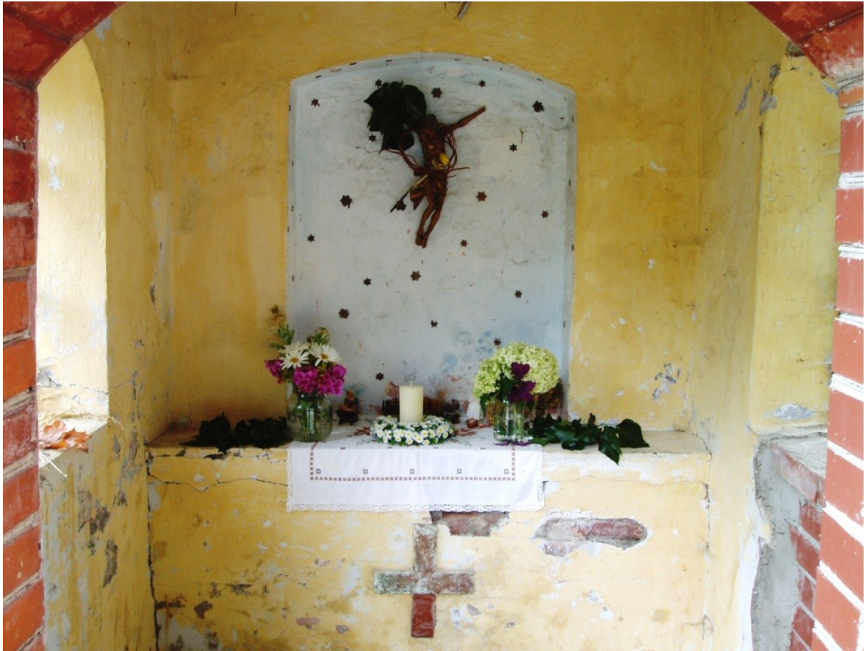
Im Süd-Osten von Oberbiberg steht eine kleine, verwitterte Wegkapelle, erbaut um 1890. 2
