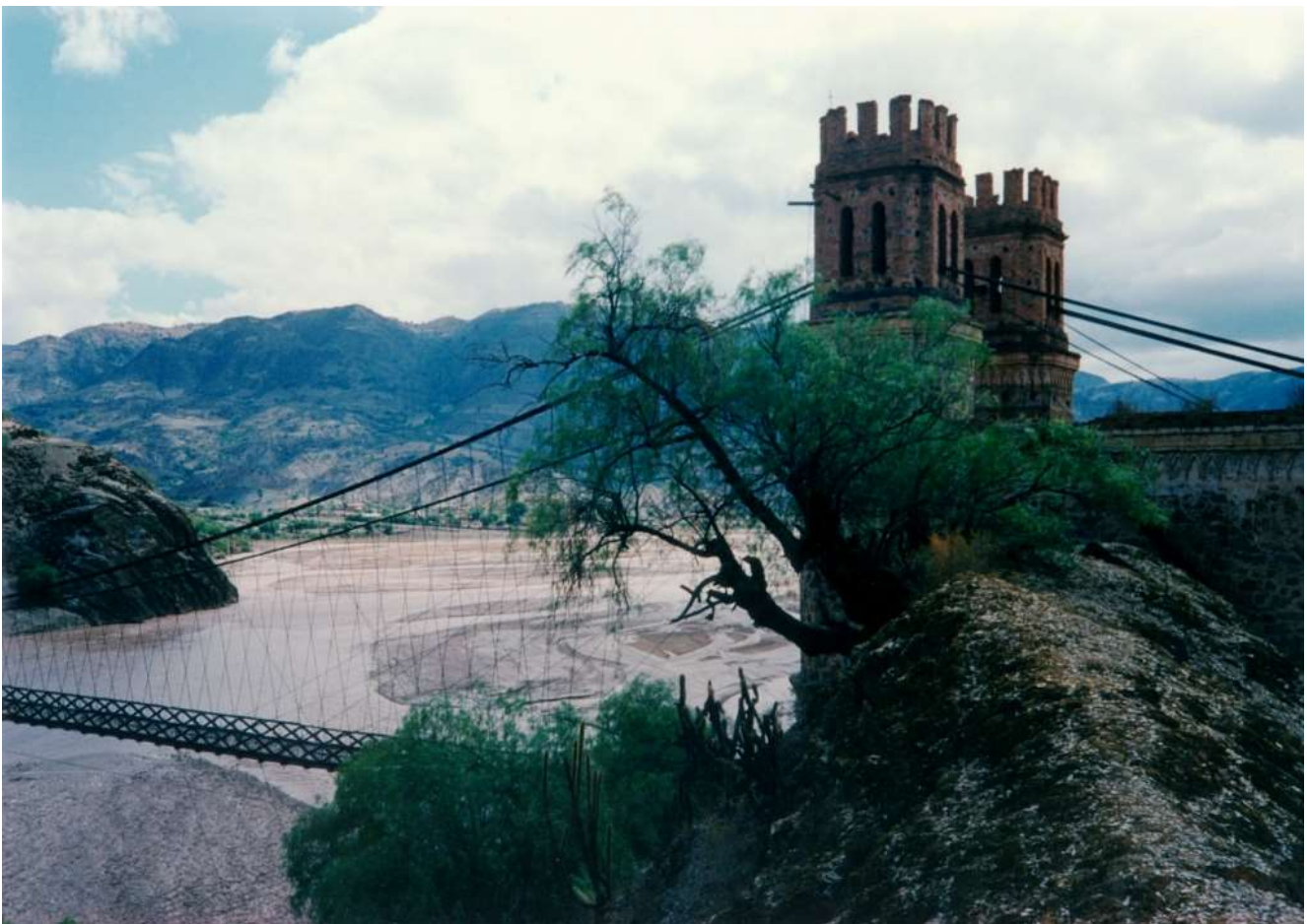
2.3.2 Historische Brücke "Puente Mendez" über den Pilcomayo Fluss Histórico "Puente Mendez" sobre el río Pilcomayo
