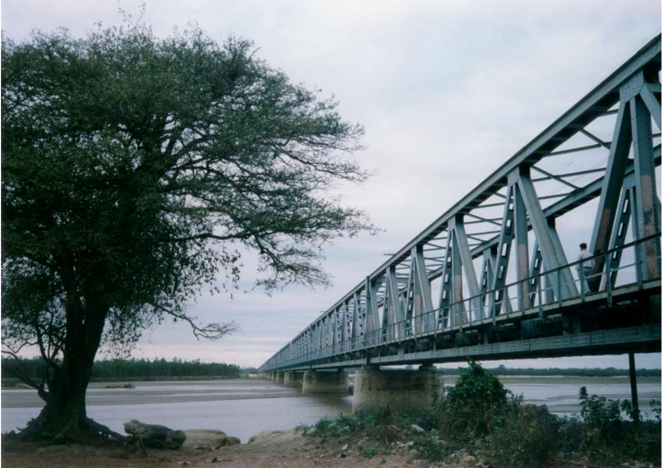
3.2.5 Puerto Pailas, Eisenbahn- und Straßenbrücke über den Río Grande Puerto Pailas, puente sobre el Río Grande
