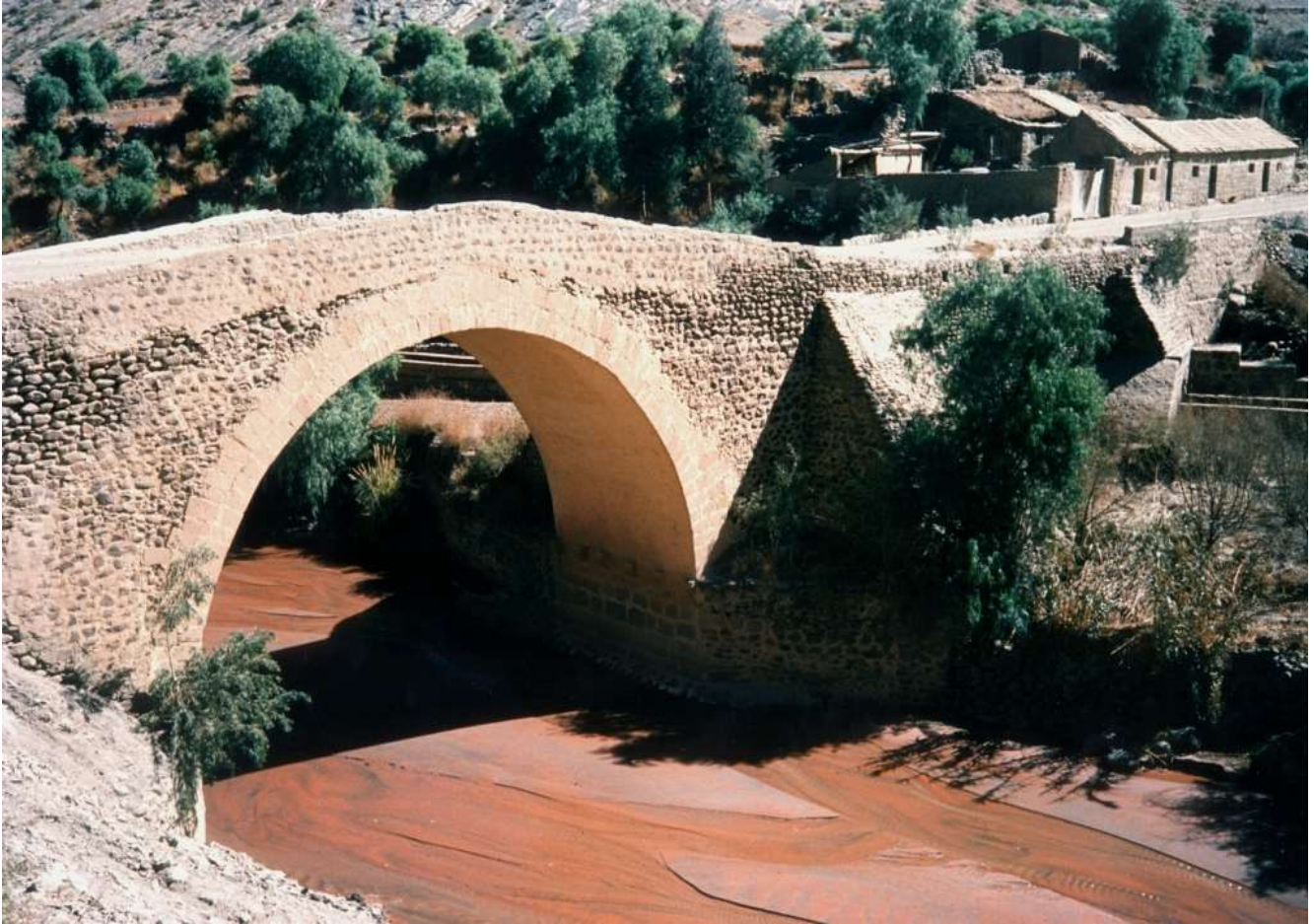
2.4.3 Bogenbrücke über den Pilcamayo Fluss Puente arqueado sobre el río Pilcamayo
