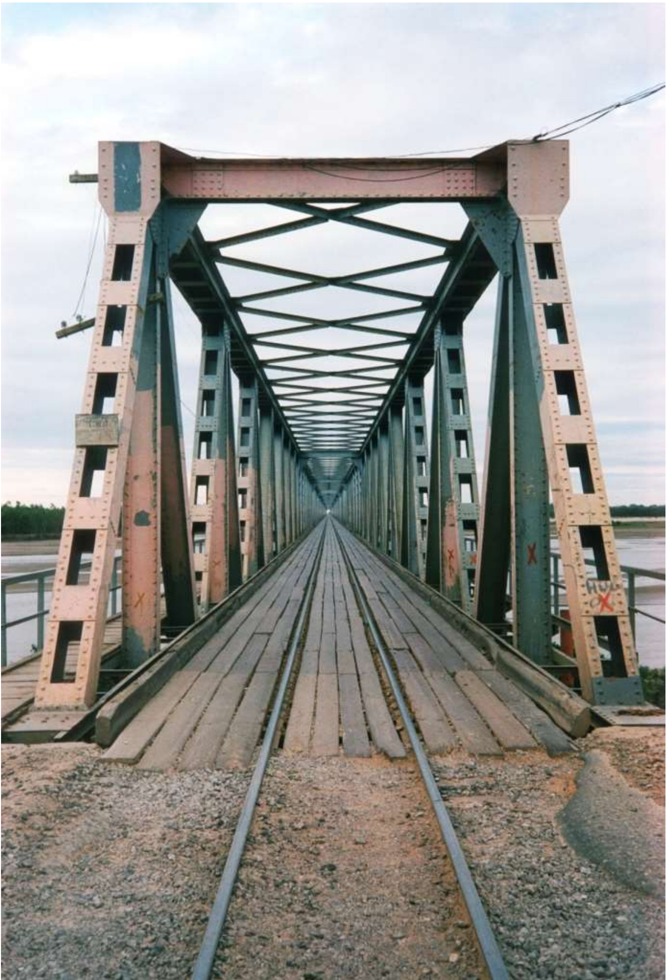
3.2.6 Puerto Pailas, Eisenbahn- und Straßenbrücke über den Río Grande Puerto Pailas, puente sobre el Río Grande
